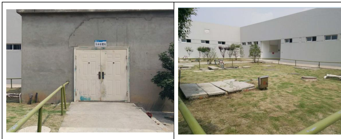
图 4.1-2 污水预处理站现场照片
