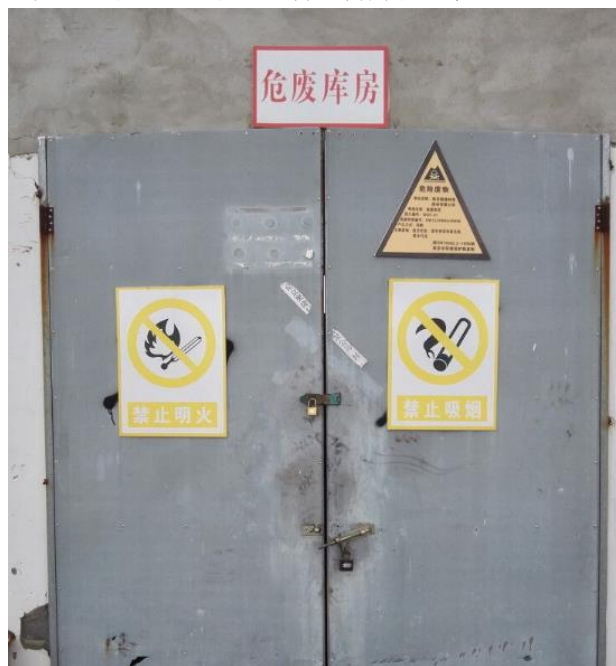
图 4.1-5 危废贮存场所现场照片
